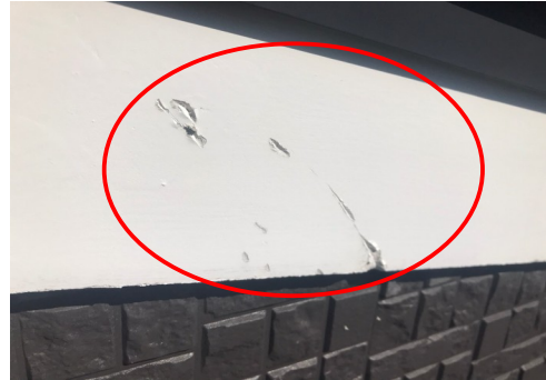
破風板 破損
