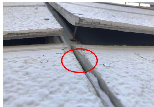
外壁 破損
